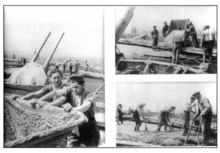
Abb. 34: Betonierarbeiten am GT Stiftskaserne. Am linken Bild ist deutlich zu erkennen, dass die Fliegerabwehrkanonen bereits vor Fertigstellung der Türme montiert wurden.
