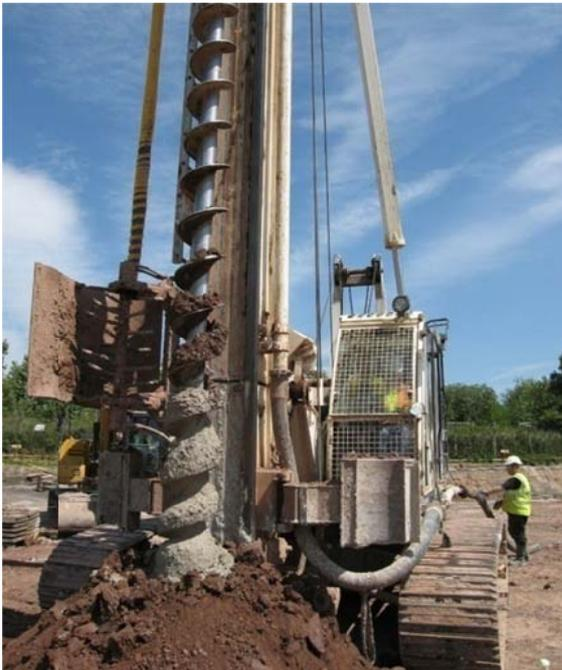
Abb. 35: Durchgehende Bohrschnecke<sup>55</sup>
