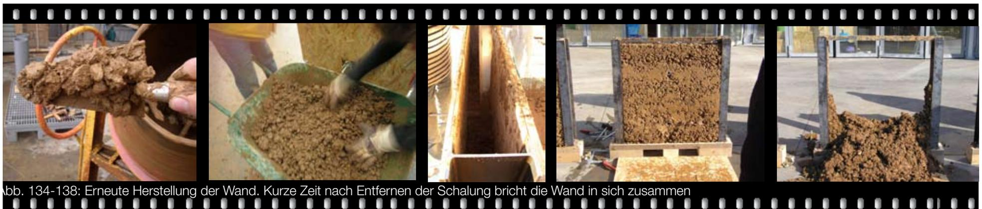
Abb. 134-138: Erneute Herstellung der Wand. Kurze Zeit nach Entfernen der Schalung bricht die Wand in sich zusammen
