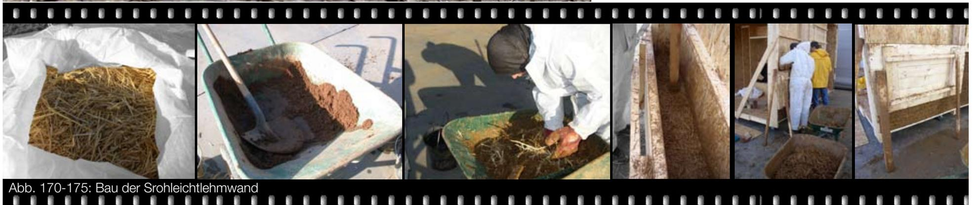
Abb. 170-175: Bau der Strohleichtlehmwand
