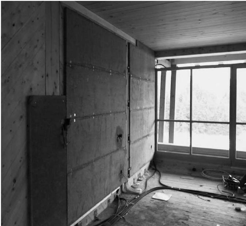
Abb. 215: Einbau von Wandheizungselementen aus Lehm
