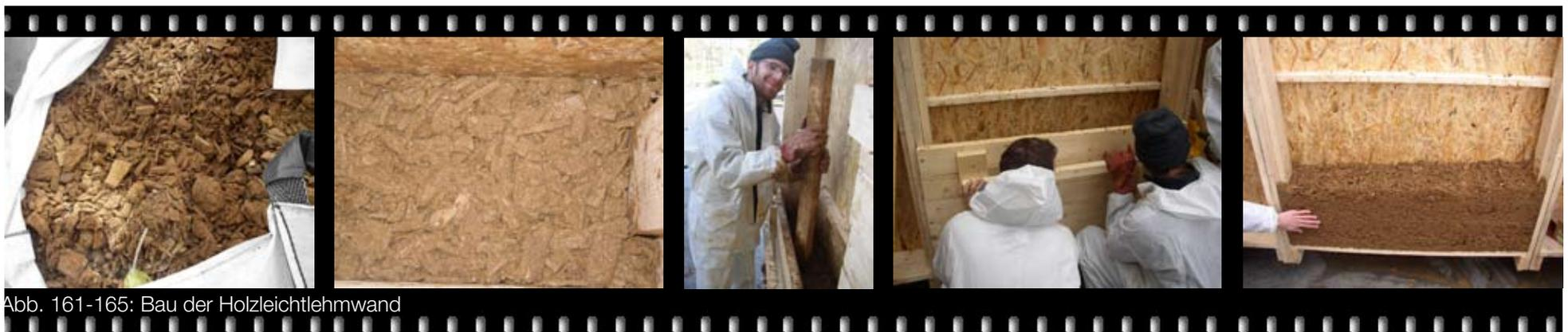
Abb. 161-165: Bau der Holzlehmwand
