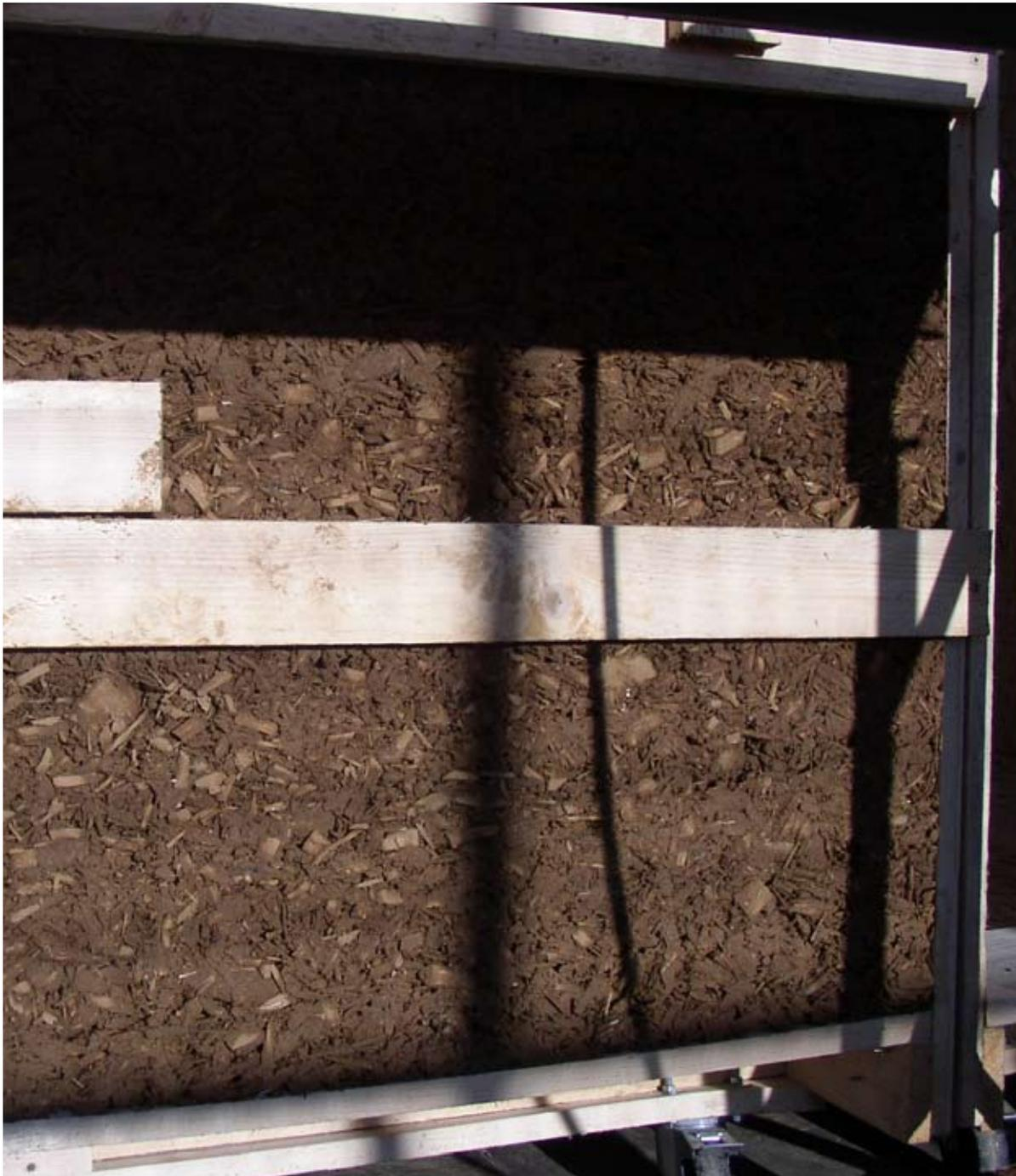
Abb. 168: Holzleichteilwand unmittelbar nach entfernen der Schalung
