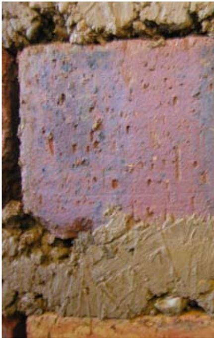
Abb. 147: Detail der Lehm-Ziegelwand
