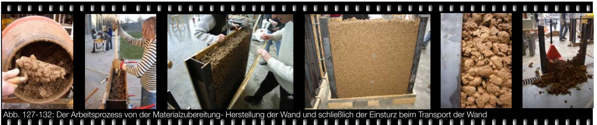
Abb. 127-132: Der Arbeitsprozess von der Materialzubereitung- Herstellung der Wand und schließlich der Einsturz beim Transport der Wand
