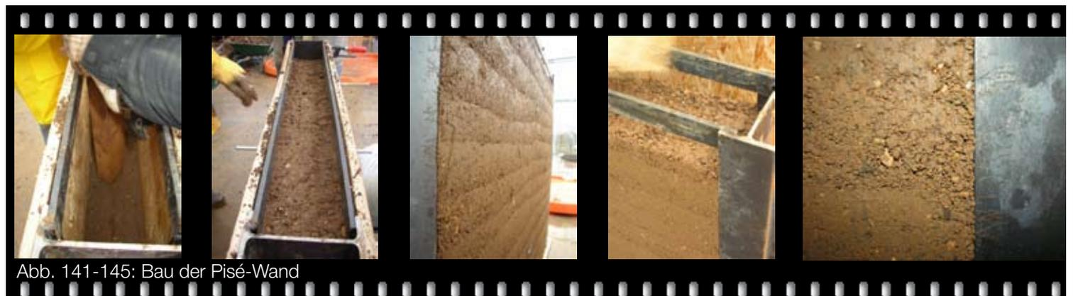
Abb. 141-145: Bau der Pisé-Wand
