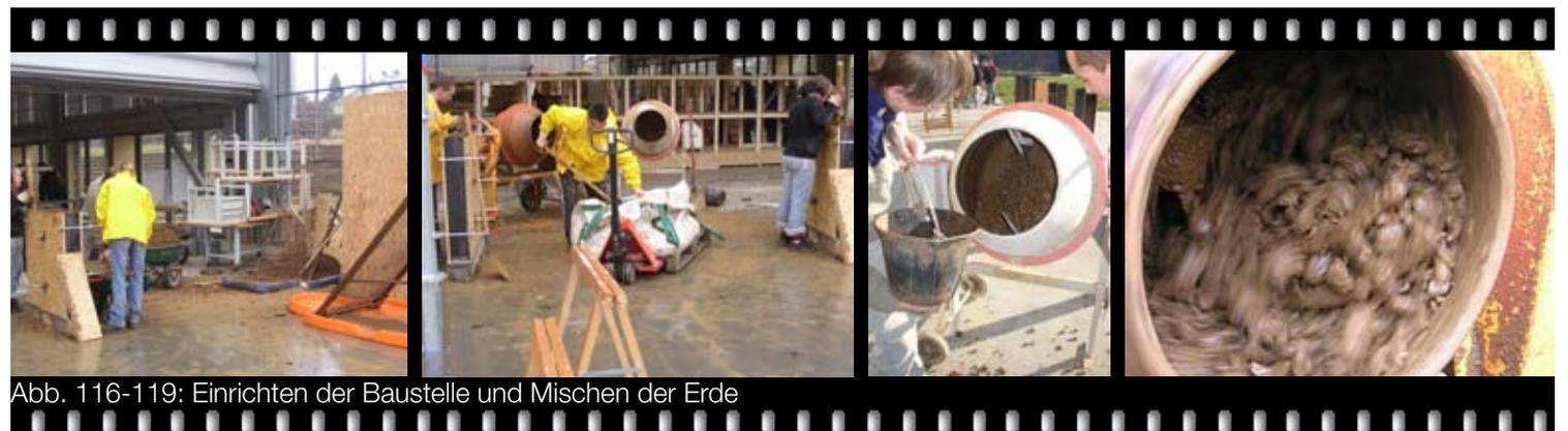
Abb. 116-119: Einrichten der Baustelle und Mischen der Erde
