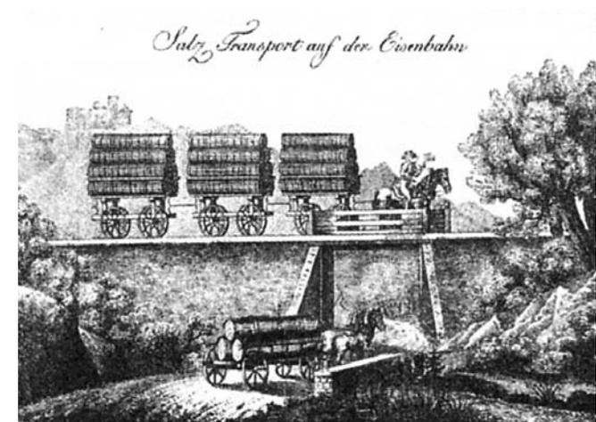
Abb. 25 Mit dieser Darstellung wollte Gerstner veranschaulichen, dass ein Pferd auf der Schiene die acht- bis zehnfache Last gegenüber dem Transport auf der Straße bewältigen könne.
