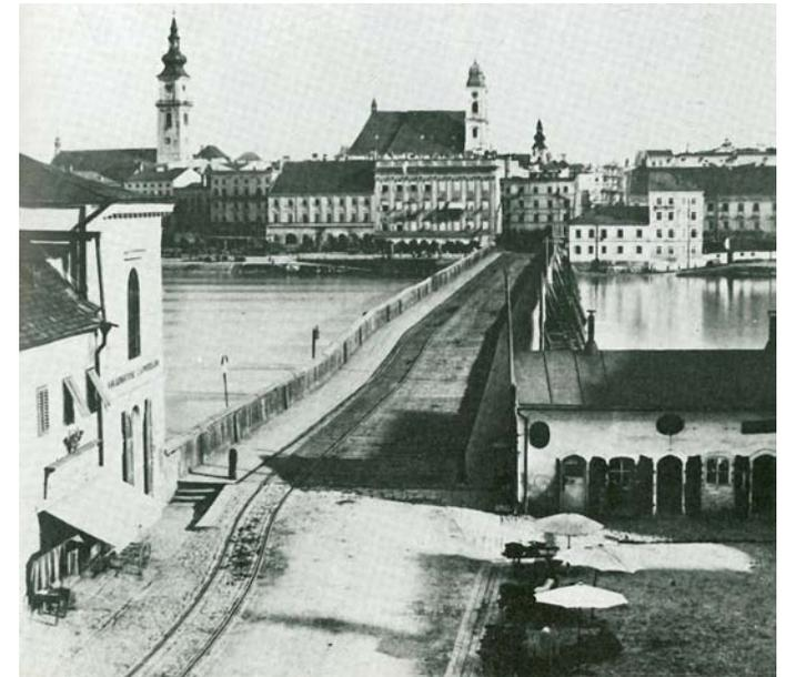
Abb. 83 Brückenkopf Urfahr mit Blick auf Linz um 1860. Die Donaubrücke wurde 1830 errichtet, sie war damit die älteste Eisenbahnbrücke am europäischen Kontinent. 1868 durch einen Schiffsanprall zerstört und danach durch eine Eisenkonstruktion ersetzt. Bahn und Straße sind nicht voneinander getrennt.
