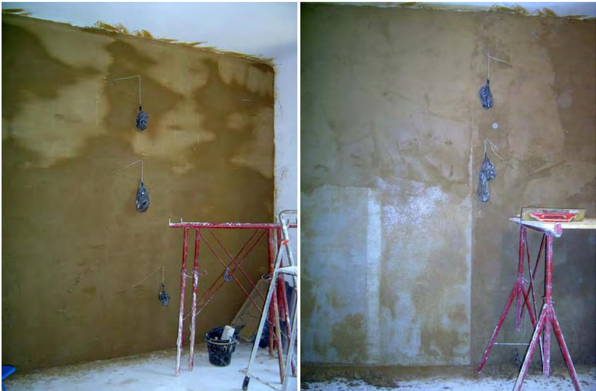
Abb. 33: Austrocknung der ersten Lehmschicht (links) und Netzen nach dem Aufbringen der zweiten Schicht (rechts)
