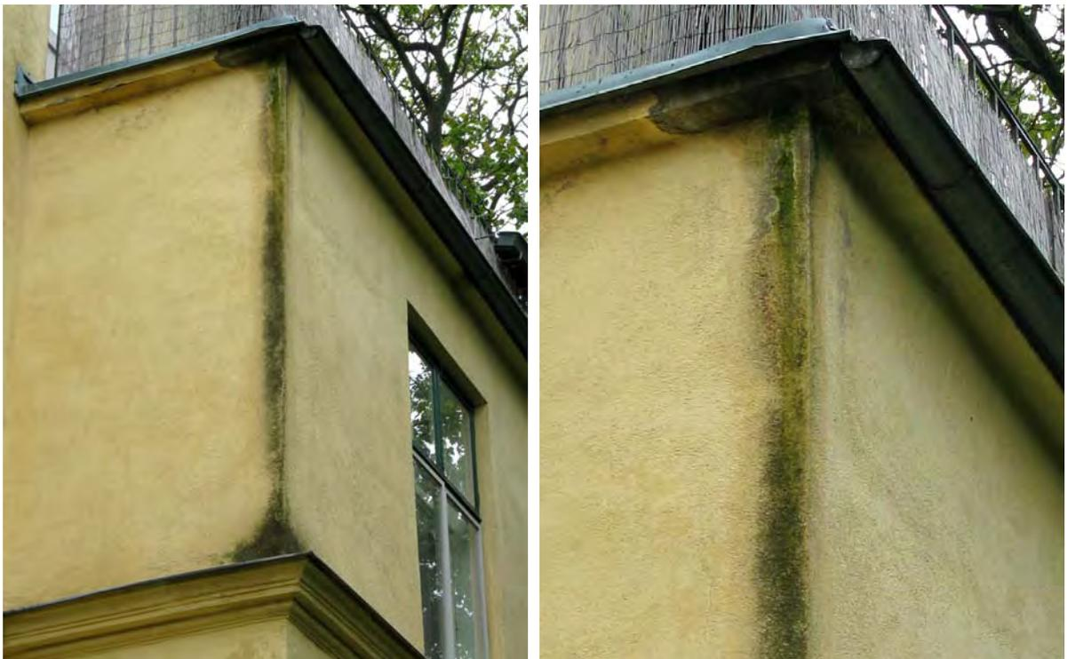
Abb. 18: Biokorrosion an einer Fassadenkante infolge einer undichten oder falsch geneigten Dachrinne
