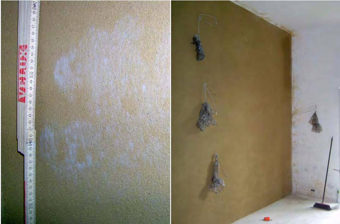
Abb. 36: Schimmelwachstum an der Lehmputzoberfläche      Abb. 37: Fertig verputzte Lehmwand mit Datenloggern
