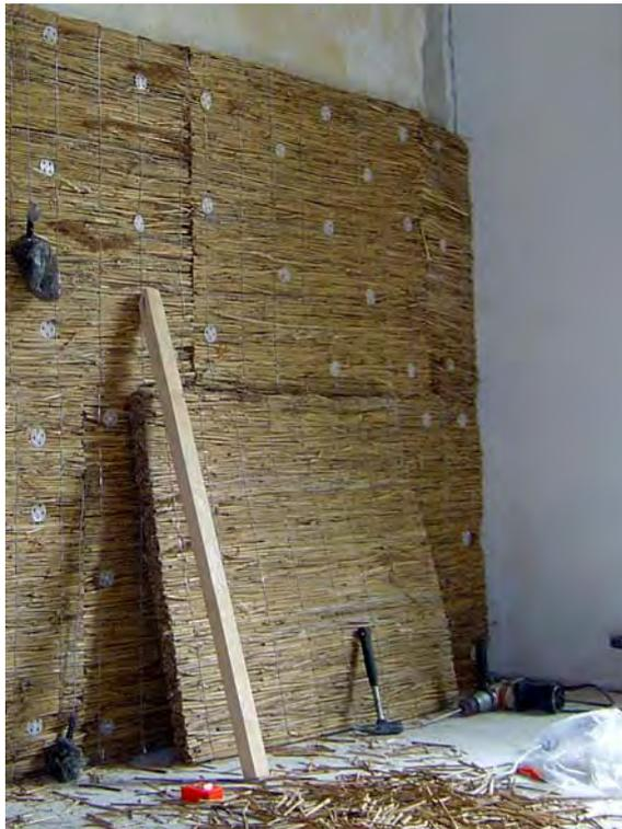
Abb. 55: Anschluss der Schilfdämmung in der Außenecke
