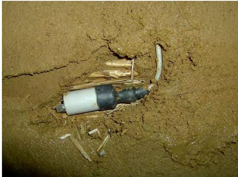
Abb. 35: Der Sensor CH6 wird direkt in den Lehmputz eingelegt.
