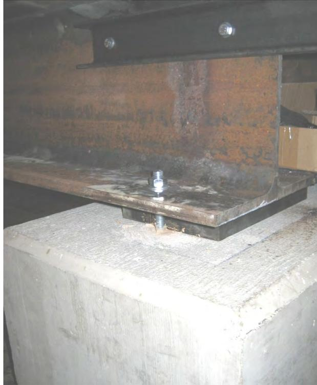
Abbildung 3.13: Auflagerausbildung mit Fixierungsanker und Elastomereissen
