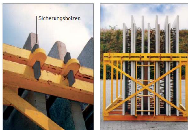
Abbildung 21: Sicherungsbolzen und Transportbox für Doppelwände 79
