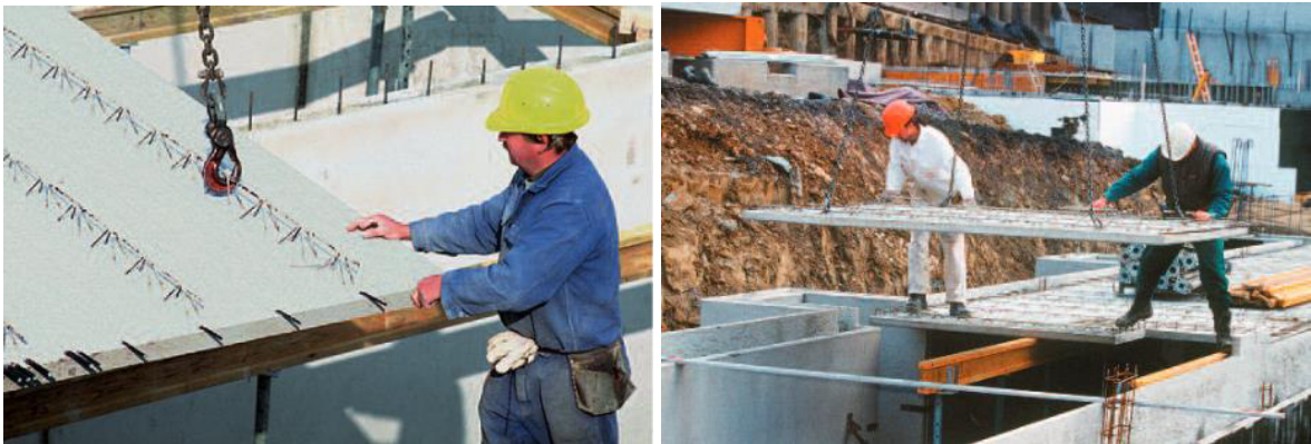
Abbildung 31: Versetzen von Elementdecken 102
