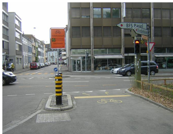
Abbildung 71: Baulich abgesetzte Verkehrsinsel für Radverkehr, Basel (CH), Foto: Tadej Brezina, Aufnahme: Mai 2014
