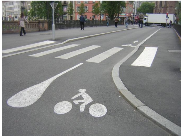
Abbildung 72: Markierung einer Verkehrsinsel für den Radverkehr, Straßburg (FRA), Foto: Tadej Brezina, Aufnahme: Mai 2014
