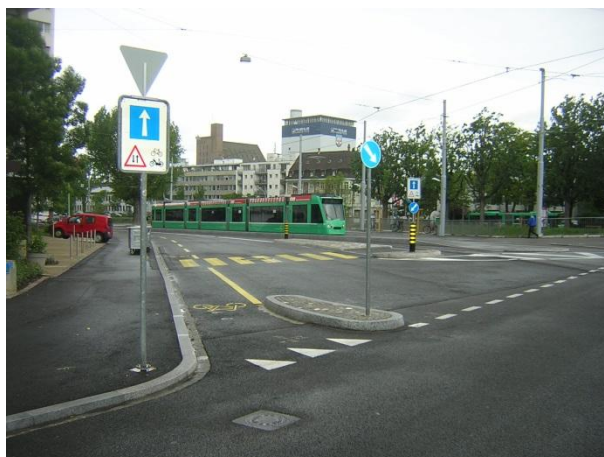
Abbildung 74: Baulich abgesetzte Verkehrsinsel für Radverkehr bei geöffneter Einbahn, Basel (CH), Foto: Tadej Brezina, Aufnahme: Mai 2014
