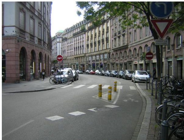
Abbildung 73: Bauliche Verkehrsinsel für Radverkehr bei geöffneter Einbahn, Straßburg (FRA), Foto: Tadej Brezina, Aufnahme: Mai 2014
