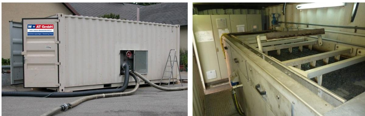
Abbildung 50: MÜSE (Maschinelle Überschussschlammverdickung); links: Außenansicht des Containers; rechts: Innenansicht Seihband und Schaltschrank)
