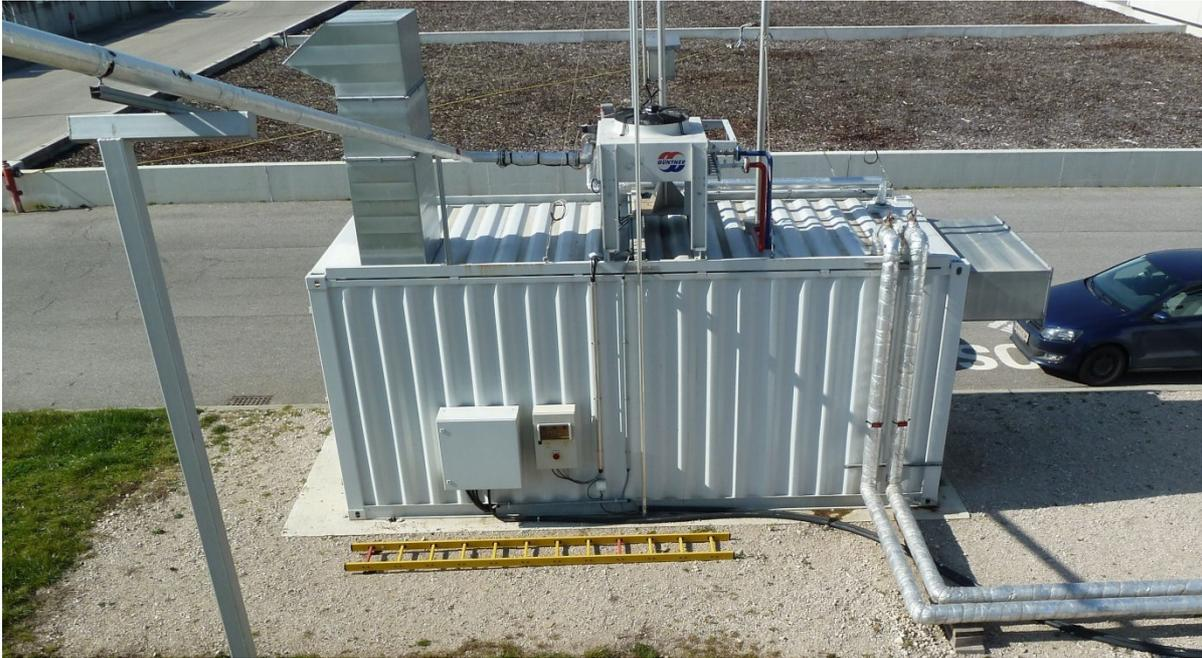
Abbildung 57: Blockheizkraftwerk (BHKW) der Versuchsanlage; Blick vom Faulbehälter (Aufnahmedatum: 11.03.2014)
