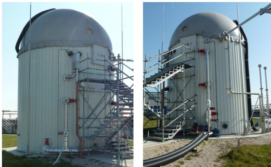
Abbildung 55: Faulbehälter; links: Entnahme und Überlaufkasten; rechts: Zulauf, Gasleitung (Aufnahmedatum: 11.03.2014)
