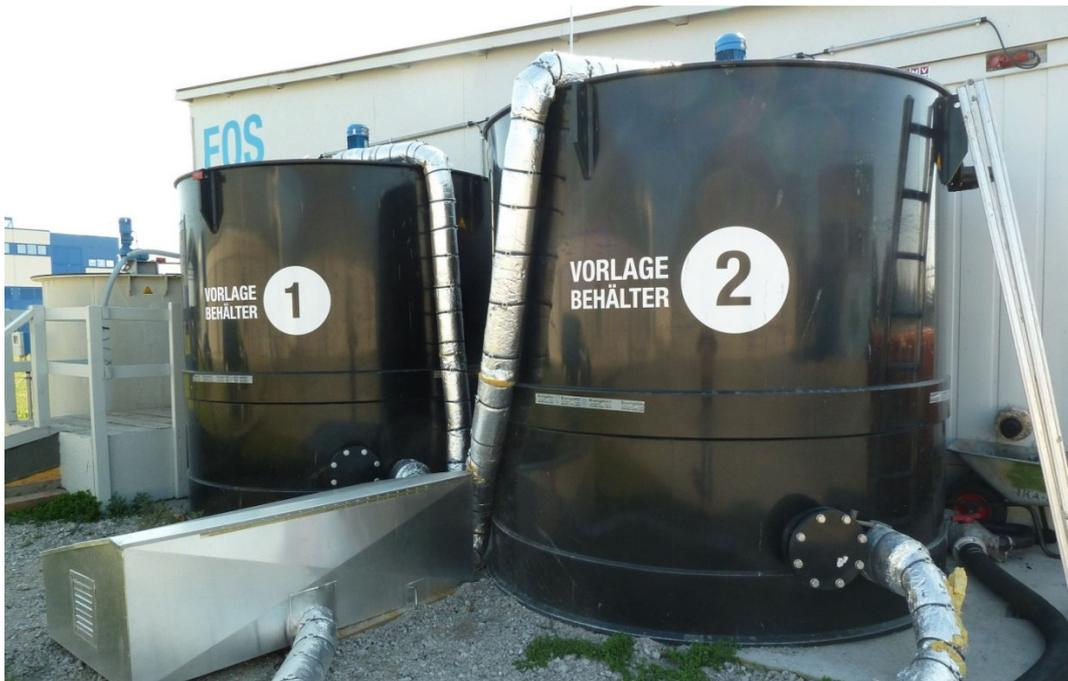
Abbildung 45: Vorlagebehälter 1 und 2 (Speicherbehälter für Rohschlamm) (Aufnahmedatum: 11.03.2014)
