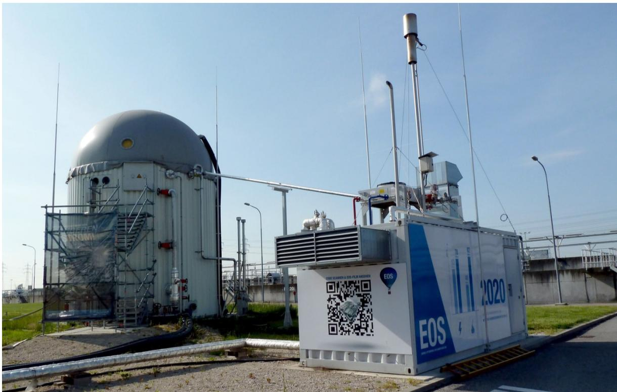
Abbildung 49: Versuchsanlage, Außenansicht: Faulbehälter und BHKW (Aufnahmedatum: 17.04.2013)
