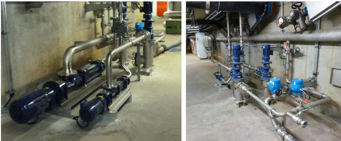
Abbildung 44: Schlammumpen im Keller beim Mischbauwerk; links: Pumpen; rechts: Verrohrung (Aufnahmedatum: 11.03.2014)
