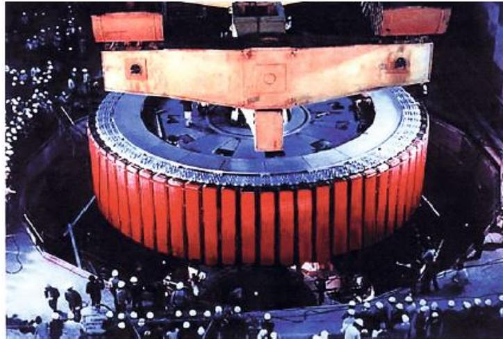
Abbildung 3.1: Läufer eines 66-poligen ( $p=33$ ) Schenkelpolgenerators [15]
