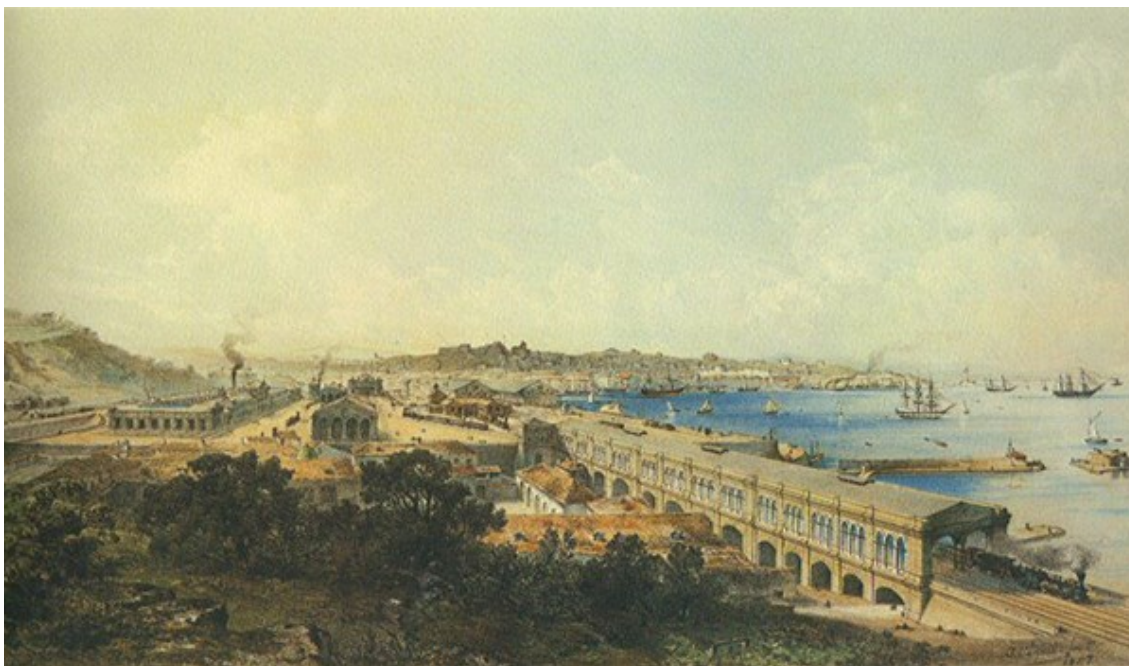
Abbildung 23: Viadukt zur Überwindung des Alten Lazaretts „Heilige Theresa“
