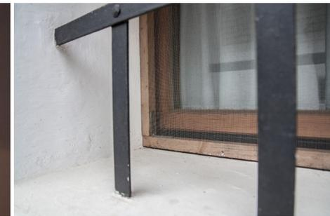
Abb.255 Detailaufnahme eingeputzter Rahmen
