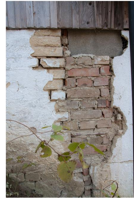
Abb.101 Sichtbares Ziegelmauerwerk Stockinger Kölla
