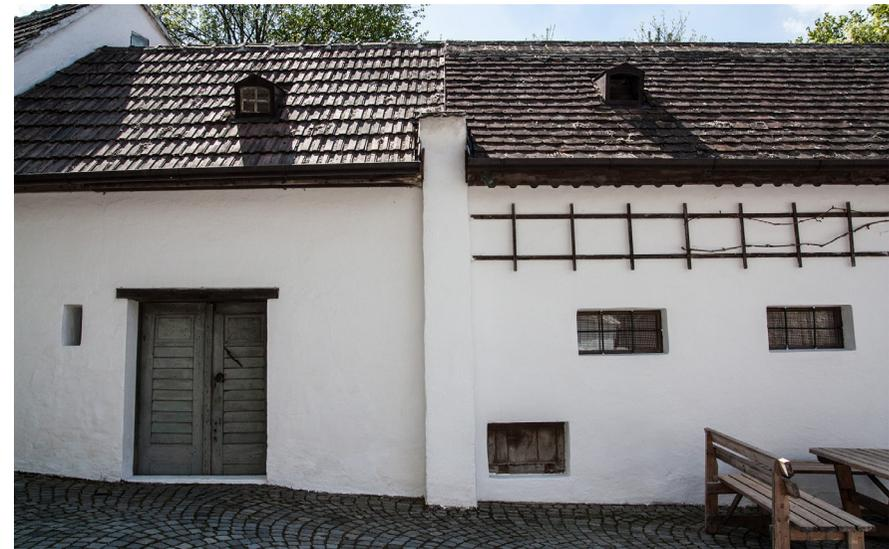
Abb.243 Teilung der Fassade durch eine Lisene sowie zweierlei Dachdeckungen
