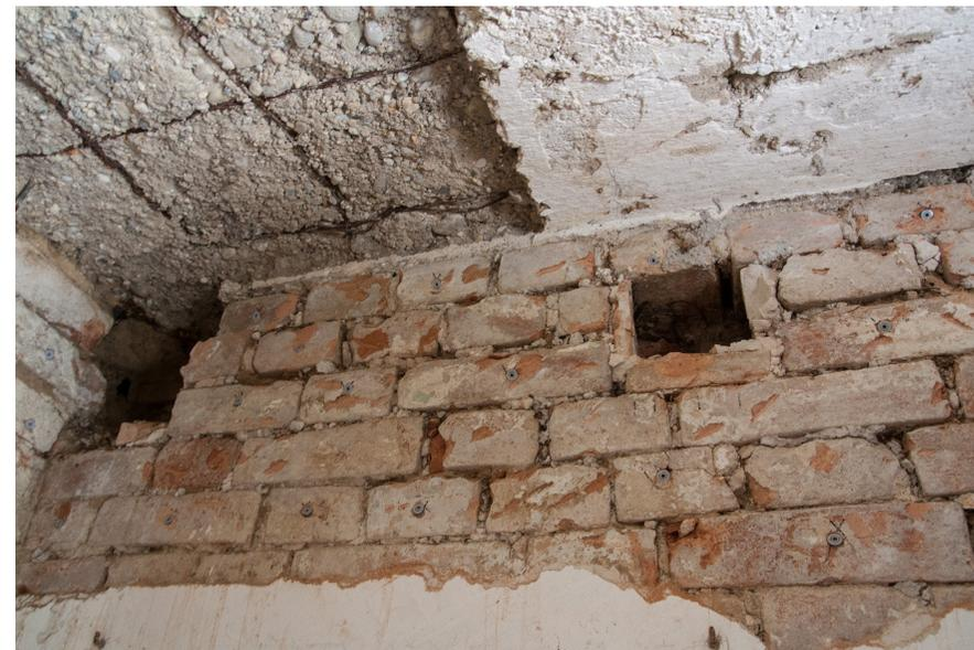
Abb.260 Sichtbares Ziegelmauerwerk und Betondecke
