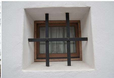
Abb.253 Fenster mit vorgesetztem Gitter
