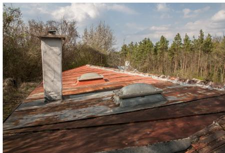
Abb.244 Dachfläche mit Lichtkuppeln und Rauchfang
